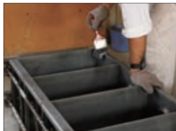
型枠に剥離剤を塗る
